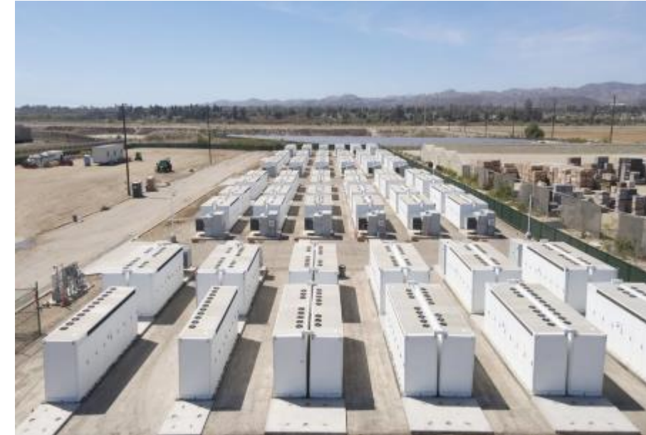
100MW/200 MWh energia tároló elhelyezése/helyigénye (illusztráció)
