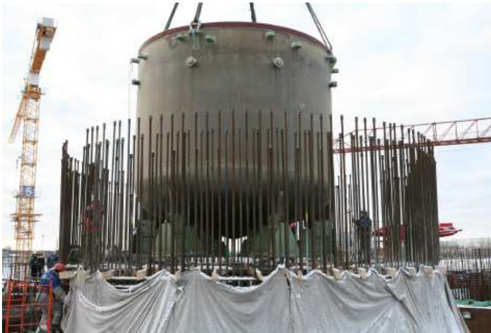
A zónaolvadék csapda elhelyezése a Leningrád-2 telephely 1. blokkján
