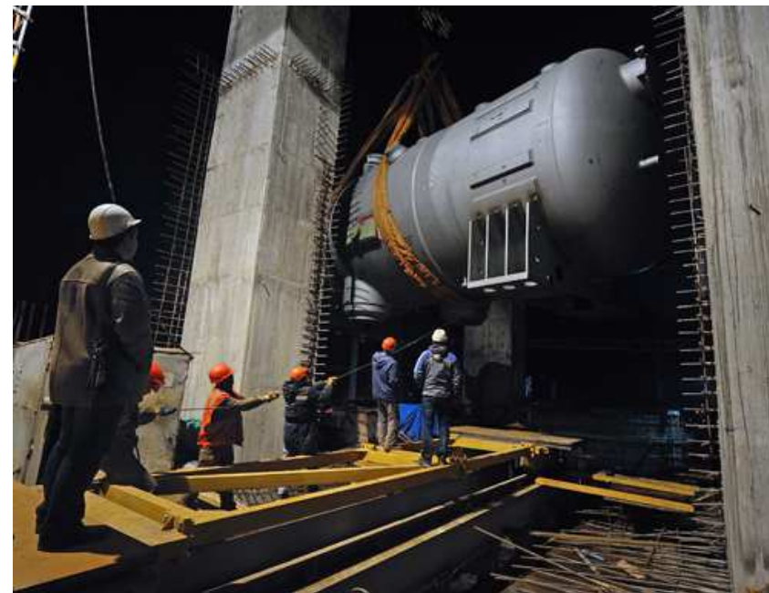
GF telepítése a Leningrád-II-1-en
